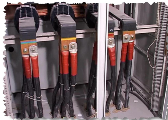
شکل ۳-۳۲: تغذیه مصرف کننده از طریق دو یا چند کابل موازی
