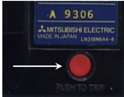
شکل ۱-۲۳: دکمه تریپ دستی کلید کامپکت
