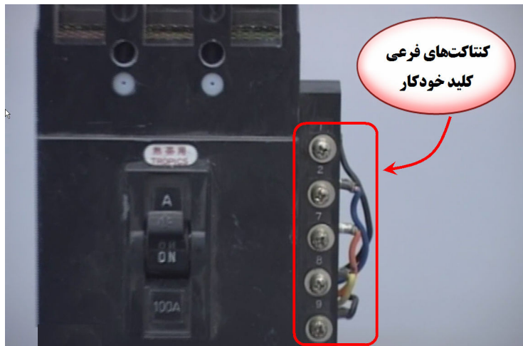
شکل ۱-۶: نمایش کنتاکت‌های فرعی کلید خودکار
